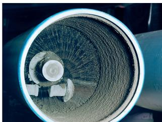
Aplicación del revestimiento interno con el proceso de lanzamiento
